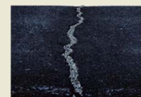
Thermal Cracking
